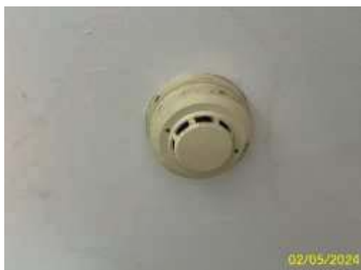
เครื่องตรวจจับควัน/หัวกระจายน้ำดับเพลิงอัตโนมัติ
